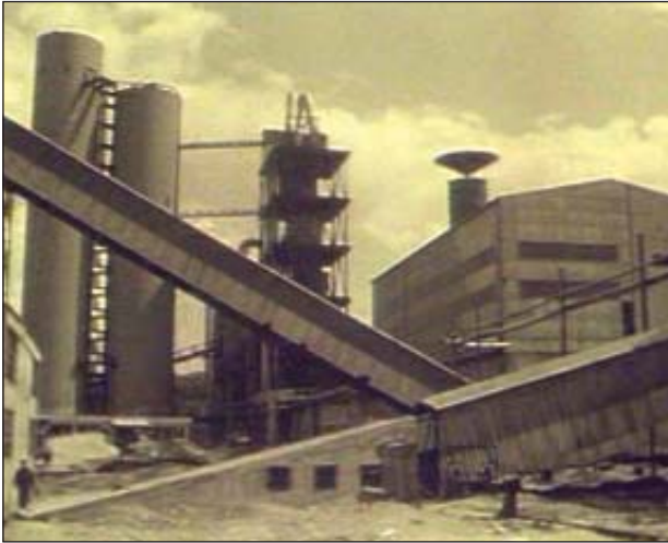
Cementara pred završetkom
