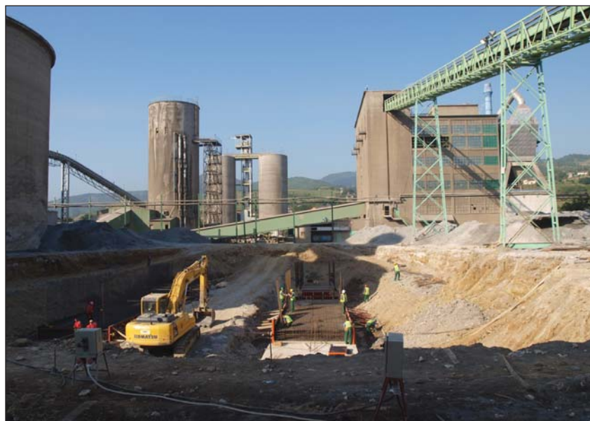
Započeta izgradnja novog silosa klinkera
