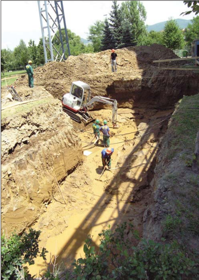
Početak izgradnje zatvorenoga cirkulacijskog sistema tehnološke vode
