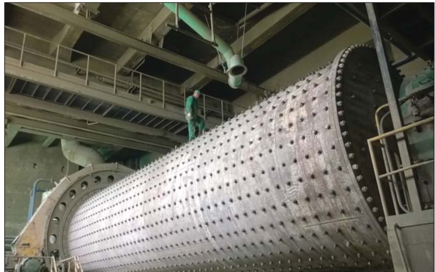
Radovi na mlinu cementa
