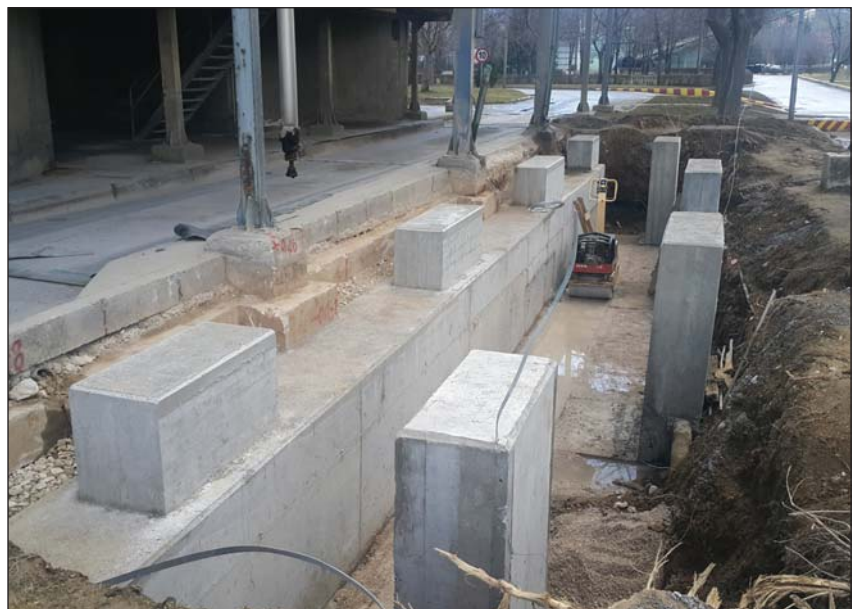
Temelji novih silosa
