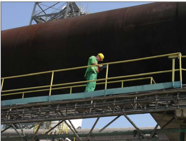
Redovna kontrola rada postrojenja
