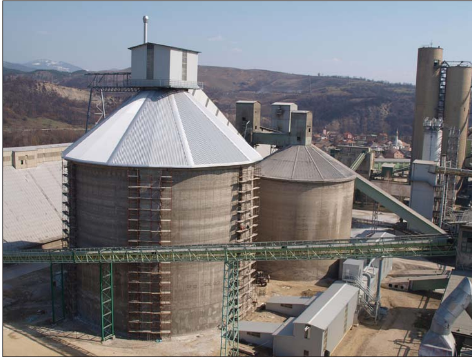
Novi silos klinkera
