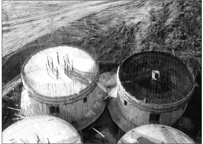
Gradnja silosa cementa
