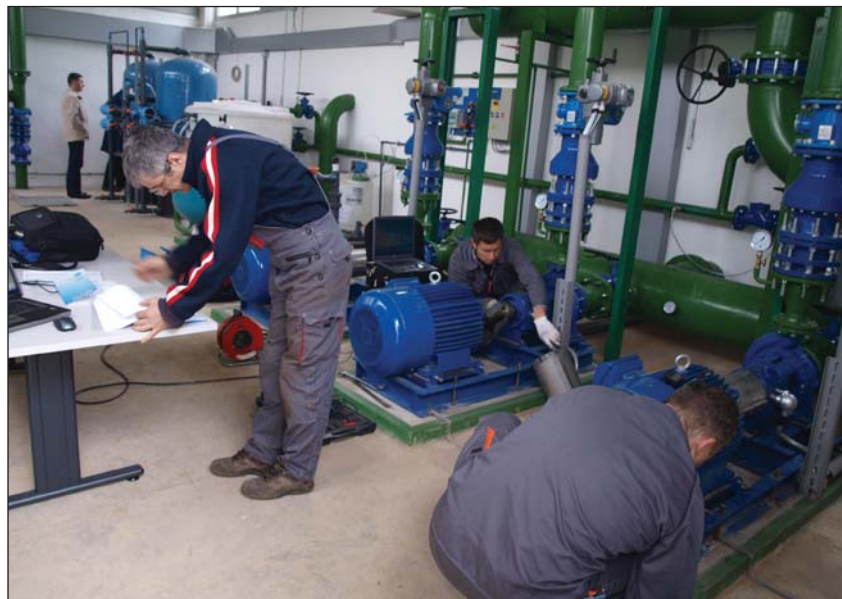
Probni rad novog sistema tehnološke vode
